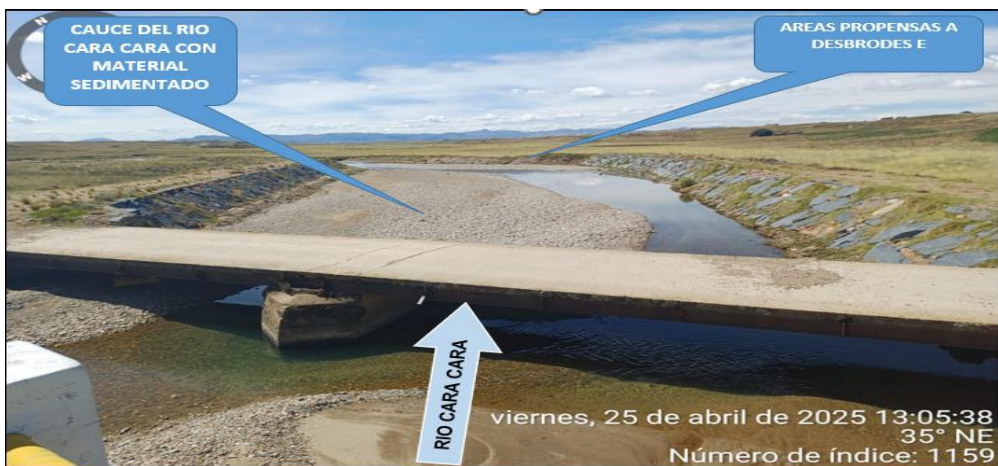
FIGURA 1 y 2 : TRAMO CRÍTICO EN EL RÍO ILLPAMAYO, EN EL SECTOR PIAS HUAYTA, DISTRITO DE LAMPA, PROVINCIA DE LAMPA - PUNO. NOTESE, LA ACUMULACION DE MATERIAL SEDIMENTADO EN EL CAUCE, QUE REQUIERE SER ELIMINADO PARA REESTABLECER LA SECCION HIDRAULICA DE LA CAJA DEL CAUCE EN ESTE SECTOR.
